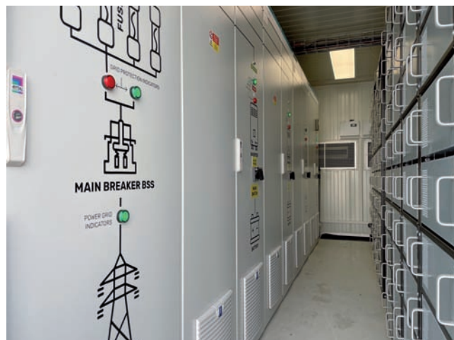
Vnútro batériového úložiska brAln
