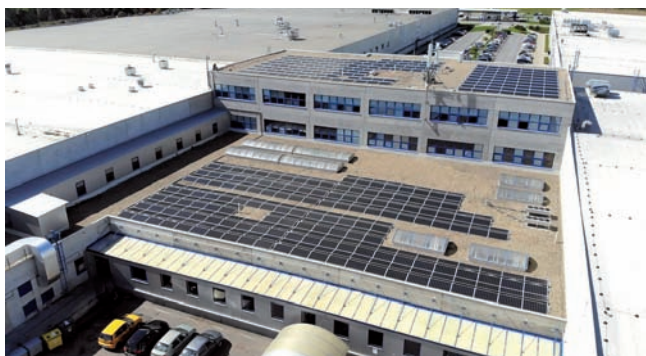
Strešná fotovoltaická elektrárň v areáli CTPark Námestovo. (Zdroj: esolar.sk)
