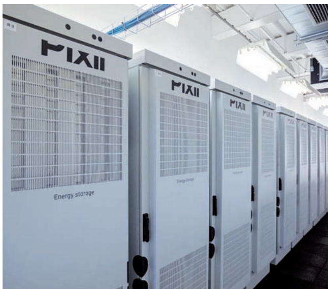
Prvé batériové úložisko v krajinách V4 certifikované na podporné služby má kapacitu 1,2 MWh a výkon 1,25 MW.
