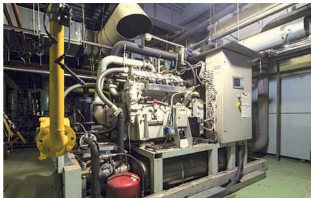
Obr. 8 Kogeneračná jednotka
